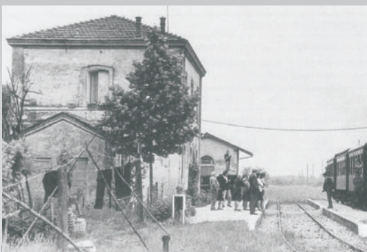
La vecchia stazione
