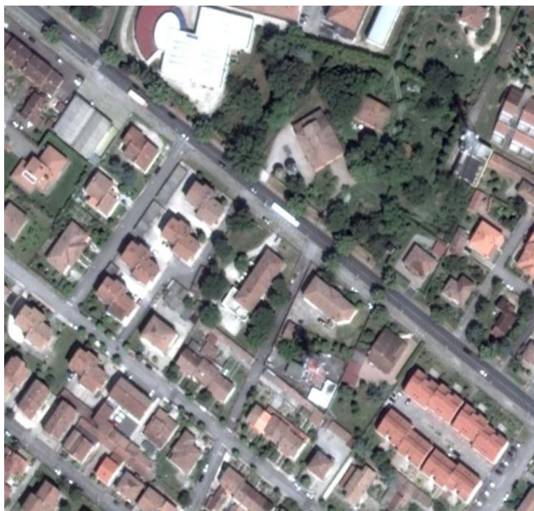
SEDE POLIZIA STRADALE Argenta
