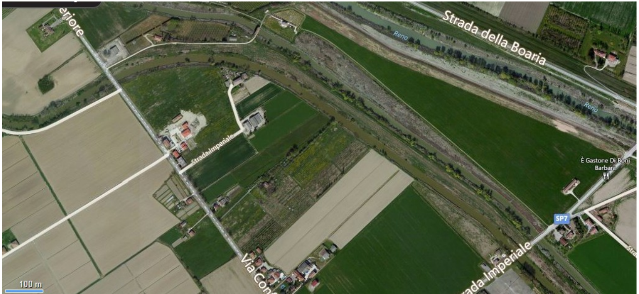
Fig. 8.6 - foto aerea (Bingmaps 2011) del canale della Botte (punto critico Ci5), nei pressi di Tragheto.
