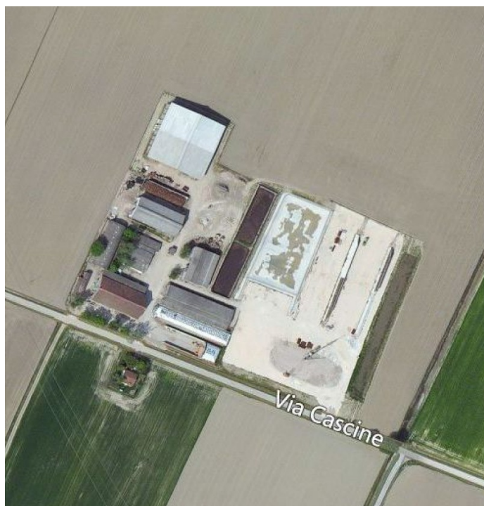
Impianto Biogas Minghini
