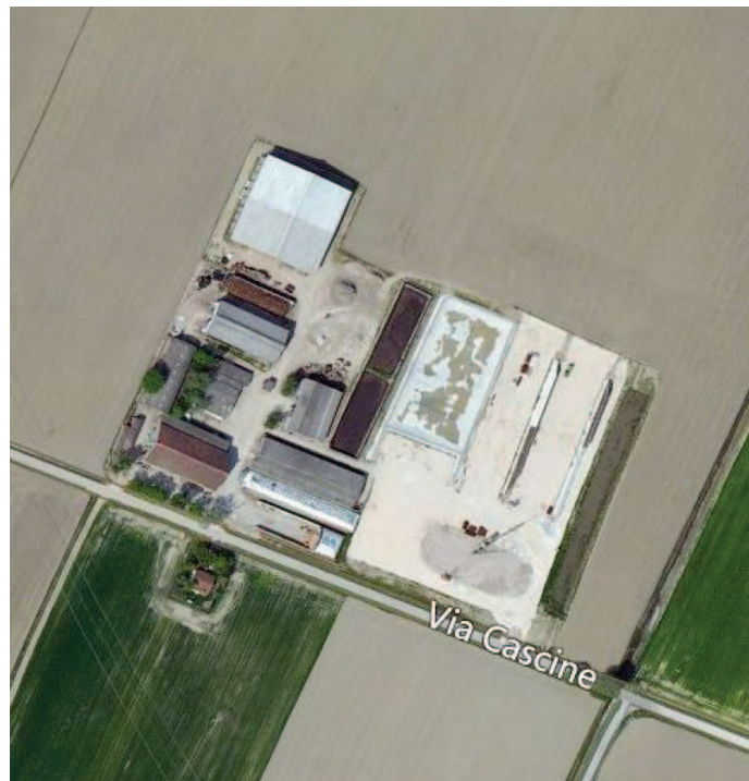
Impianto Biogas Minghini
